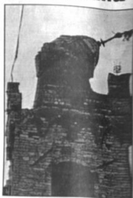
El sismo provocó la caída de la parte superior de la torre Foligno (Umbria), que era el monumento símbolo de la ciudad.
