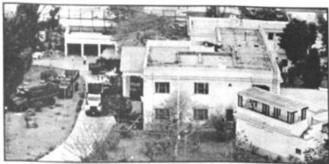
Comenzaron los trabajos de demolición de la residencia japonesa que fue escenario de un ingrato episodio de violencia.
