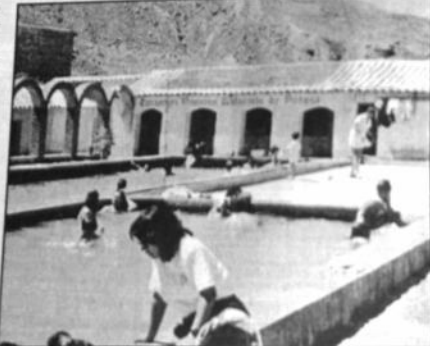
Largos meses para que se inicie el juicio por una mala obra.
