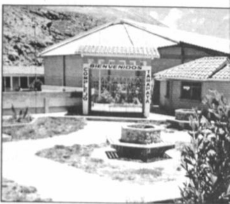
Fiscalía encuentra más irregularidades en esta obra.
