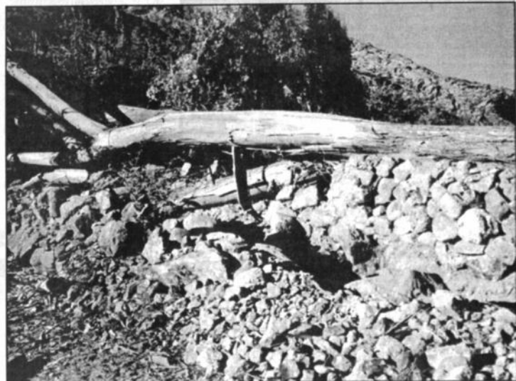
MUROS INCAICOS.- El poco cuidado de un hacendado al talar árboles, ha provocado el desmoronamiento de varios muros incaicos en la Isla del Sol.
