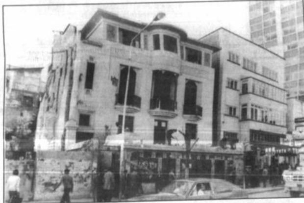
El edificio de la COB fue demolido por orden de Luis Arce Gómez.
