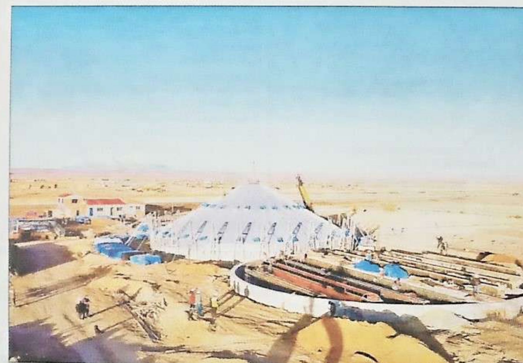
LA PAZ. La Planta de Almacenamiento y Transformación de Cereales en Viacha.
