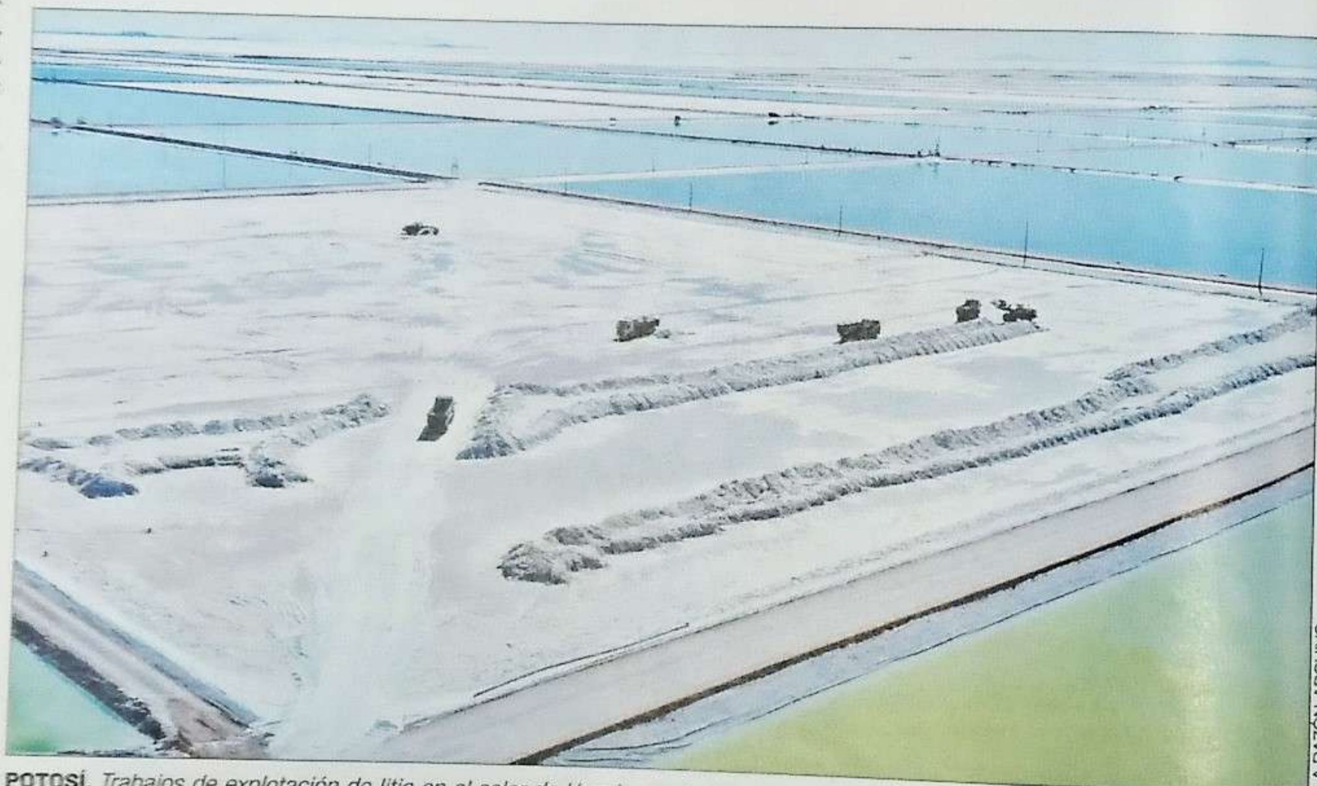
POTOSÍ. Trabajos de explotación de litio en el salar de Uyuni para la planta industrial de carbonato de litio.
