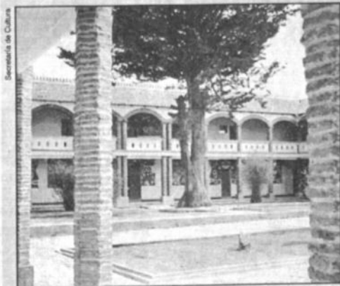
WARISATA.- La Escuela Ayllu tras los trabajos de restauración realizados en el último tiempo.
