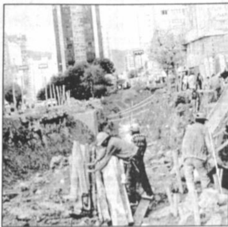
Esta obra terminará costando 1,2 millones de dólares.
