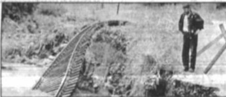
Las intensas lluvias también provocaron daños en la red ferroviaria
