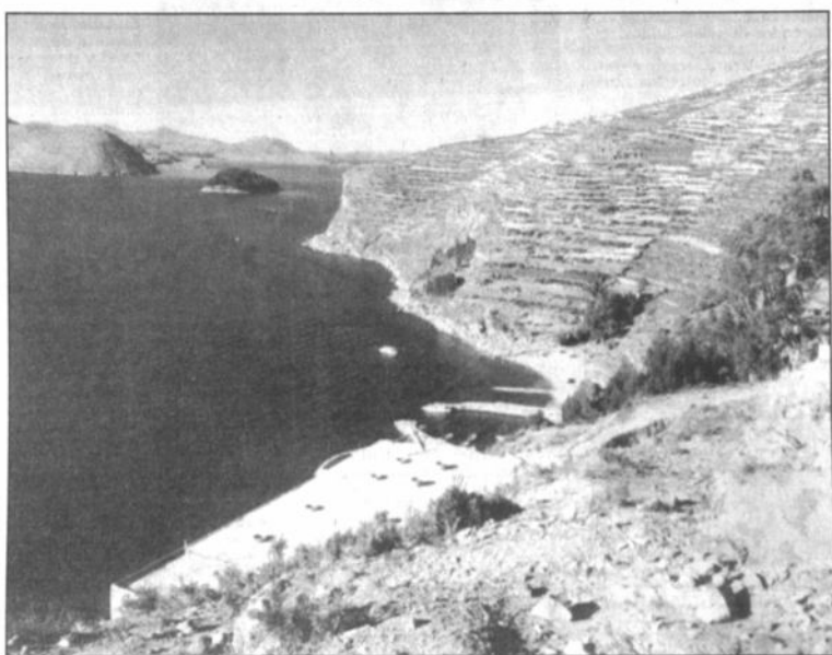
MUSEO.- En la foto se ve algo de lo que será un Museo subterráneo, construido por la empresa Transturín.
