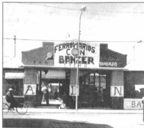
La estación de Oruro, dañada por políticos.
