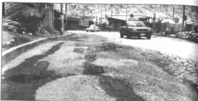
Se recompondrán las calzadas destruidas.
