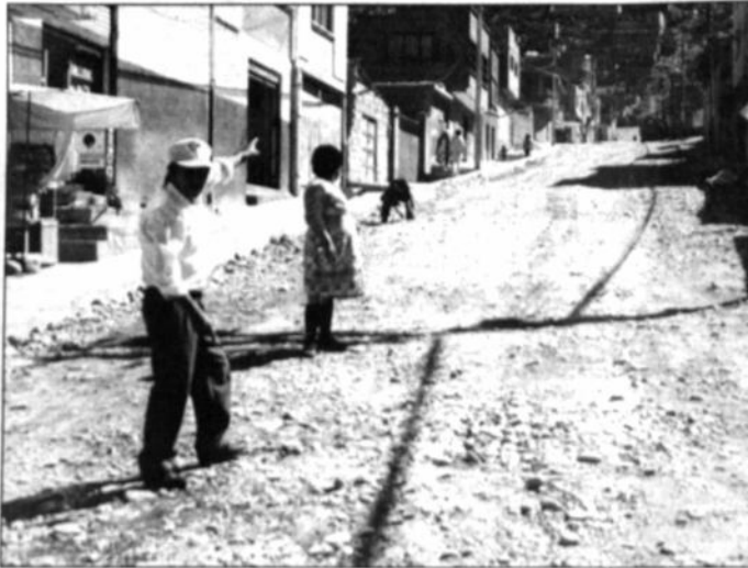
Desde allá no hay luminarias, se quejan los vecinos.
