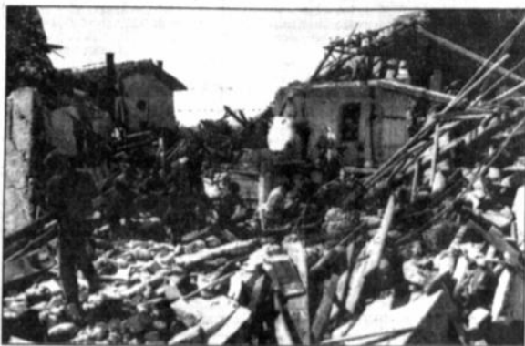
Miles de viviendas quedaron arrasadas por el terremoto (Foto archivo)
