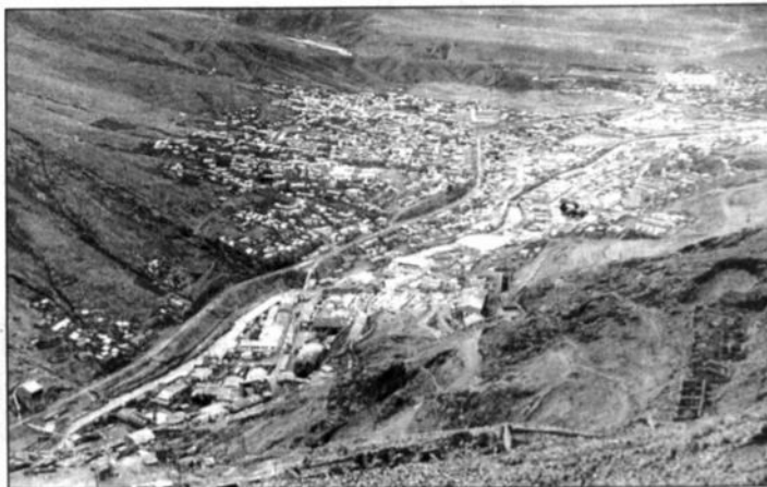
Los mineros se encuentran apostados en el cerro Posokoni, a la izquierda de la fotografía.
