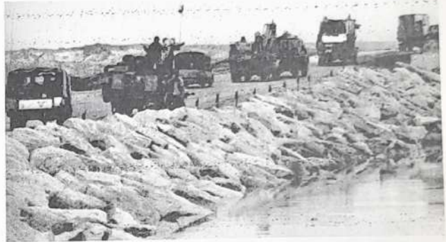
RETIRO. Tal Aviz 27 (AP). Vehículos militares israelíes atraviesan un puente sobre el Canal de Suez, al retirarse de la margen occidental. (Radiofón AP especial para PRESENCIA).
