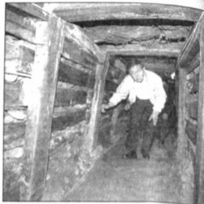
El túnel que logró la gloria de Fujimori.
