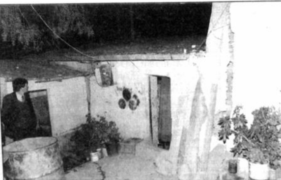
Anoche, una de las viviendas que se resiste a desplomarse.
