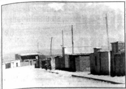
Tienen energía eléctrica pero no luminarias; en las noches los delincuentes hacen de las suyas.
