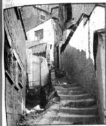
Al pensar en pasar por este callejón.
