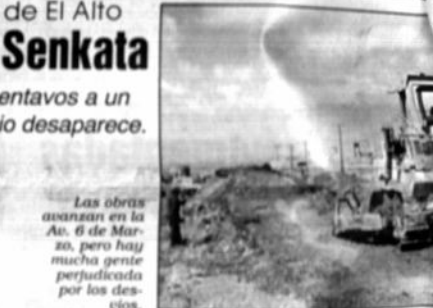
Las obras avanzan en la Av. 6 de Marzo, pero hay mucha gente perjudicada por los desvíos.
