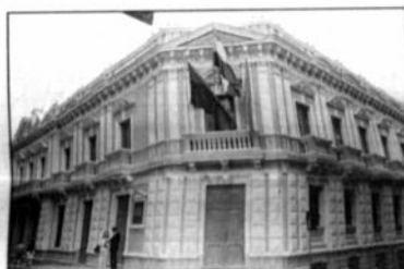
La refacción de este edificio está en su etapa final.
