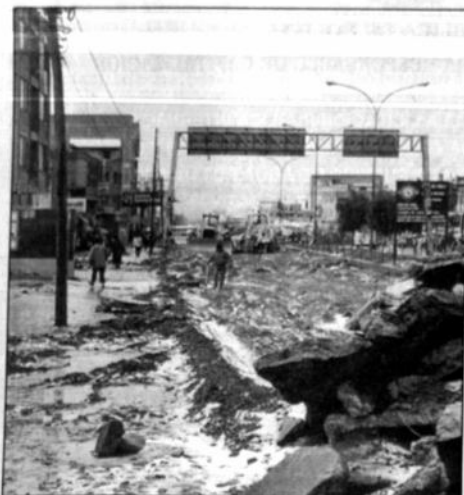
La obra que tanto esperan ver concluida los alteños tropieza con obstáculos.
