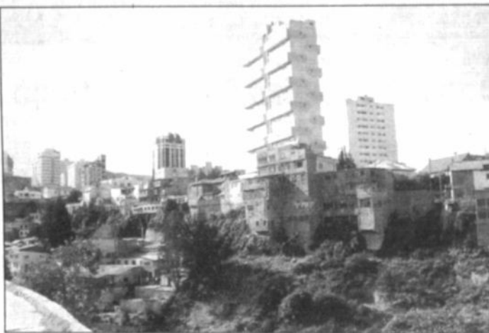
Muchas lluvias y filtraciones. Una zona en riesgo.
