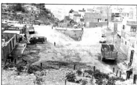
ZONA DE LA VITA. - Calles aledañas que cobrarán actividad con la puesta en marcha del proyecto del distribuidor vial.
