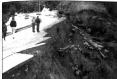
La plataforma del asfalto del carril de subida de la Av. Kantutani fue socavado por filtraciones subterráneas.
