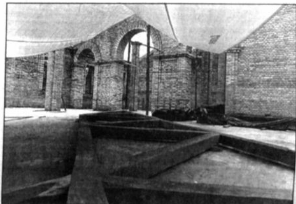
Vista parcial de una de las monumentales cerchas de 26 metros de longitud.
