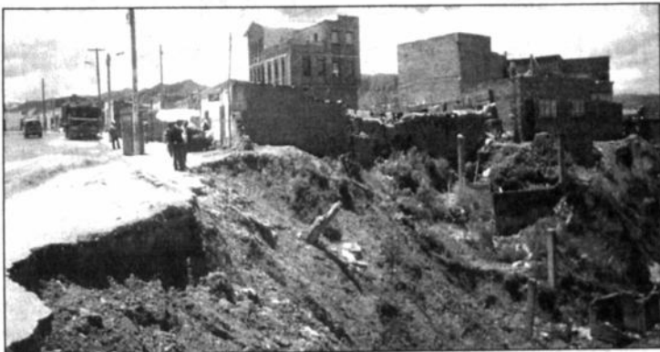
PELIGRO.- Esta zona está declarada en emergencia, pero los vecinos notificados para que abandonen sus viviendas se resisten a hacerlo.
