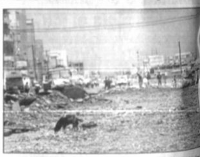
Los trabajos en la Av. 6 de Marzo dificultan el tráfico vehicular.
