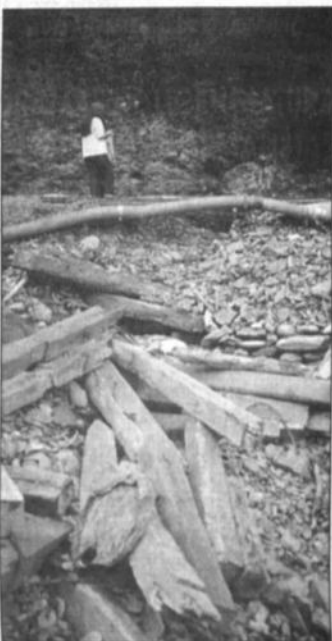
Vigas podridas y astilladas que alguna vez dieron soporte a los socavones
