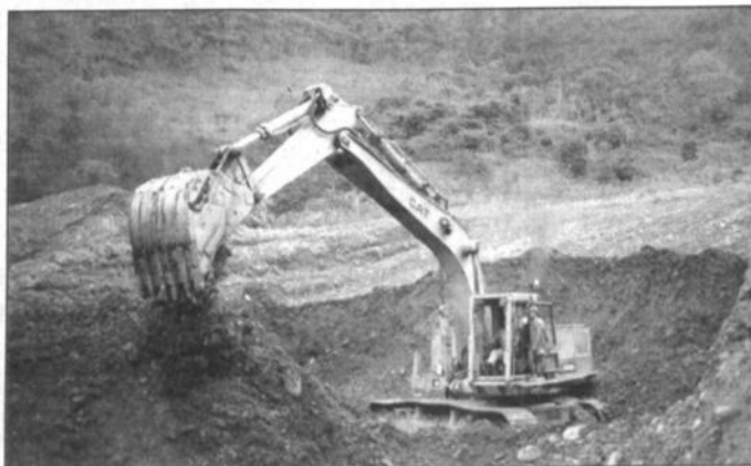
Maquinaria pesada para la extracción de oro. El gasto en diesel y los elevados volúmenes de tierra removidos encarecen este tipo de explotación.
