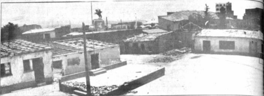
Los padres de familia de El Alto aportan económicamente para la construcción de aulas y la refacción de pupitres.
