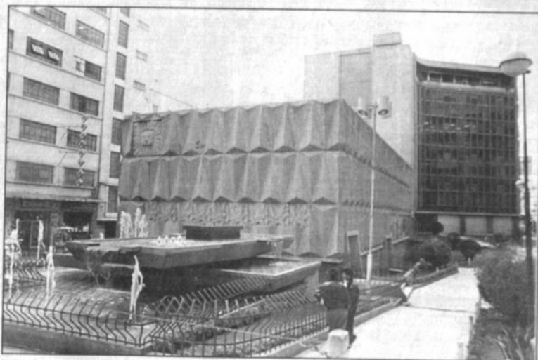
CASA DE LA CULTURA.- Construida hace 20 años, hoy en refacción general.
