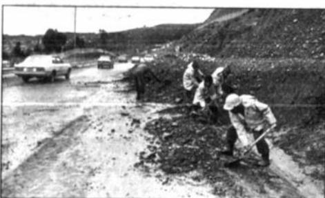
La causa fundamental del derrumbe fue el taponamiento del desagüe.
