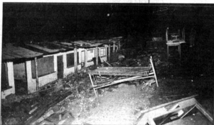
Sólo quedaron lágrimas, calaminas retorcidas y vigas rotas.
