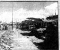
Algunas obras que se comenzaron no pudieron ser concluidas.
