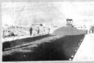
Colocado del geotextil, Av. Villazón (obra: Pavimentado y drenaje pluvial de las zonas Este y Sur)
