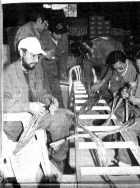
Trabajadores de COTEL reemplazan cable de fibra óptica en lugar de cable de cobre, para la conversión de sistema analógico al digital.
