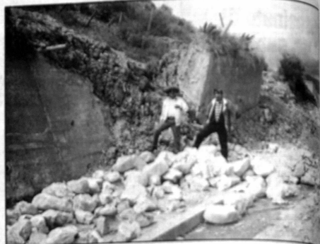
La fotografía muestra el derrumbe del muro de contención en el Cementerio "La Llamita" o Pokeni, ubicado en la curva 27 de esa zona.
