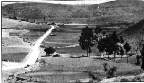
La construcción de caminos, el principal pedido.
