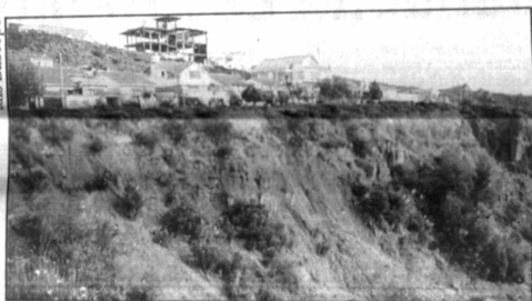
Seis casas del barrio Libertad corren el riesgo de derrumbarse si la Alcaldía no realiza los trabajos de prevención necesarios.
