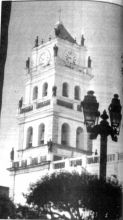
La restauración se centrará en las cubiertas laterales del templo.
