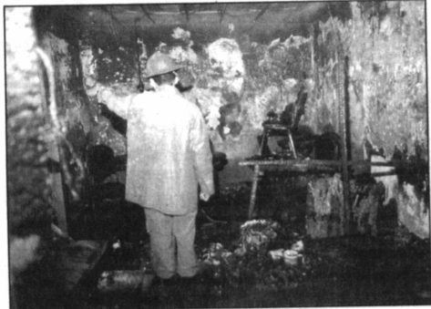
Así quedó el "snack" Paulis luego del incendio del pasado sábado. Los vecinos de Sopocachi alertan que a pocos pasos está una gasolinera de la Policía, la que no tiene un extinguidor.
