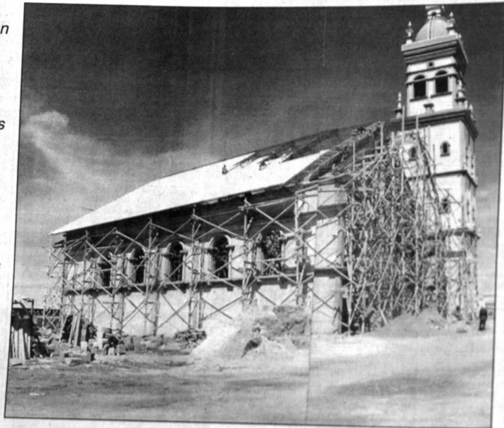
Otra construcción de gran magnitud acompañará en breve a la Catedral de El Alto en la urbanización Cosmos.
