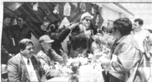
Acto de inauguración de obras en la escuela de Villa Nuevos Horizontes I.
