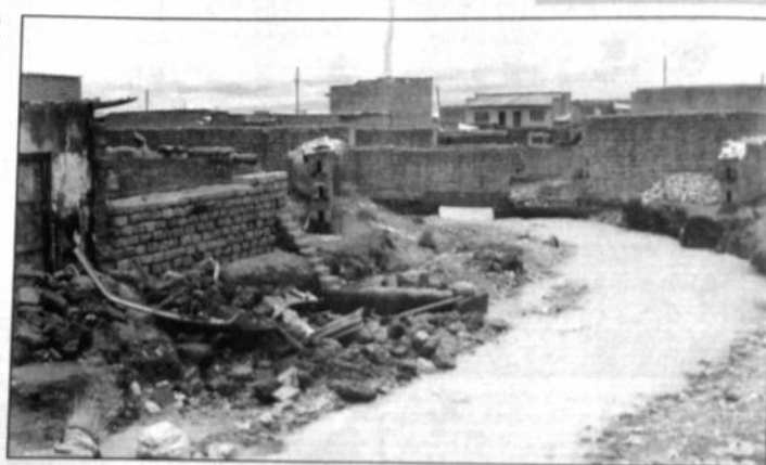
El río Kantutani se ha convertido en un extenso mingitorio a consecuencia de que las villas no tienen alcantarillado y agua potable.
