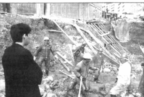
La Alcaldesa inspeccionó ayer las obras de emergencia.
