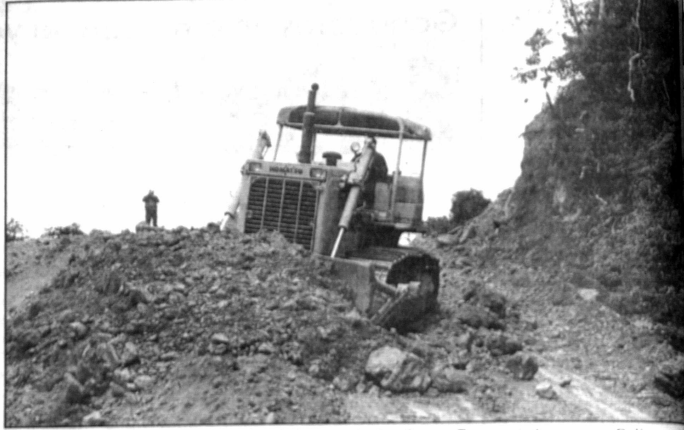
En malas condiciones están las vías de las provincias Arque, Tapacari, Ayopaya y Bolívar.
