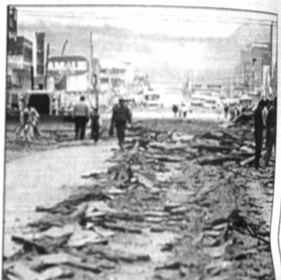
La Prefectura se adelantó a la Alcaldía en trabajos de construcción en la Av. 6 de Marzo.
