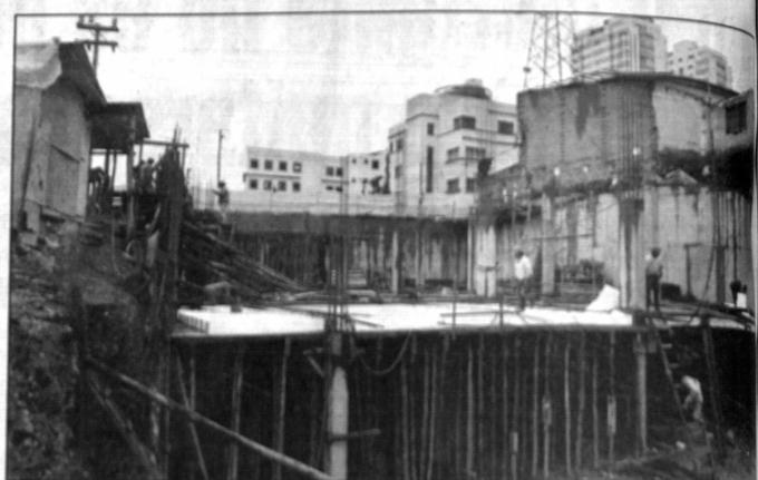
LA NUEVA CINEMATECA. Los obreros, pese a las inclemencias del tiempo, siguen su labor en lo que será la nueva Cinemateca Boliviana. Los impulsores esperan que estos trabajos no se detengan.
