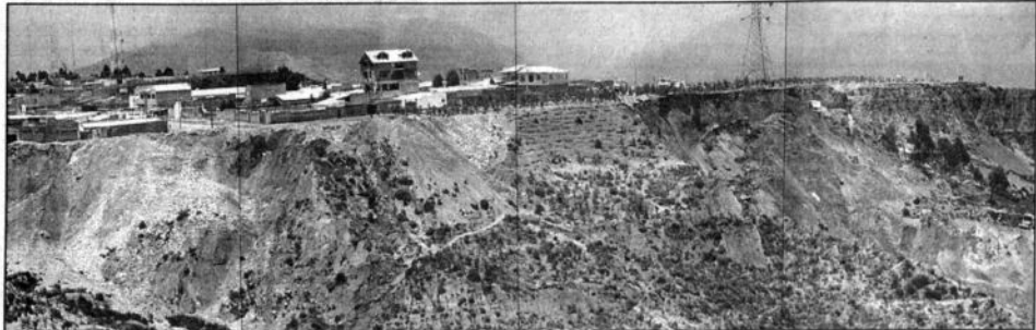
Si siguen los deslizamientos, las torres de alta tensión y las viviendas más próximas serán las más afectadas; sin embargo, para que no ocurra eso, se hacen los esfuerzos pertinentes.
