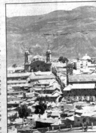
En esta ciudad el alcantarillado se encuentra muy deteriorado.
