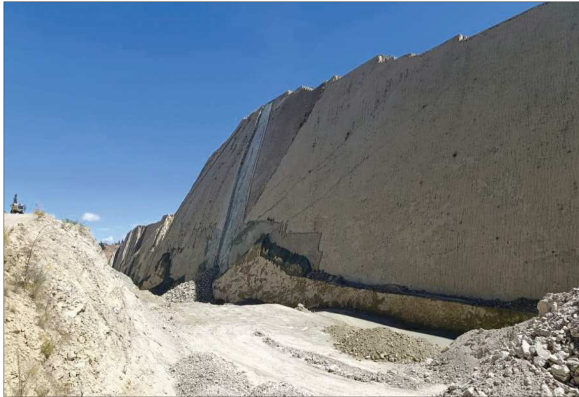
DESLAVE. La noche del miércoles se registró el colapso de una parte del farallón Cal de Orcko, en Sucre.
