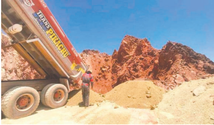
Trabajos de relleno en hundimientos en el Cerro Rico /EL POTOSÍ
