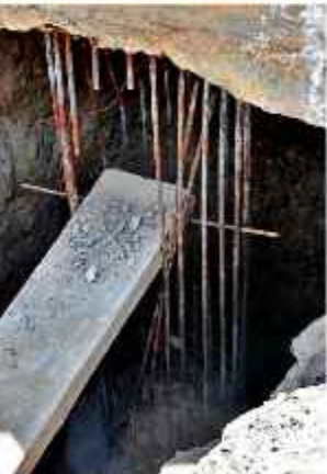
OBRAS. Trabajos en la avenida Costanera.
